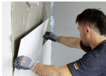
Met PCI FT Extra kunnen tegels op waterdichtingspasta PCI Lastogum worden gelijmd.
