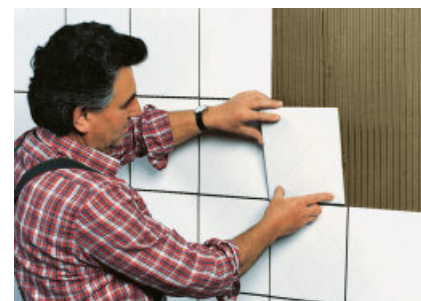
Goede verlijming in dunbed met PCI FT Klebemörtel.
