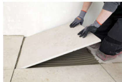
Middenbedverlijming met PCI Carrament.
