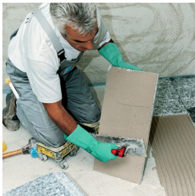
Om holtevrij te kunnen verlijmen wordt in principe een lijmlaag op de rugzijde van de plaat aangebracht.
