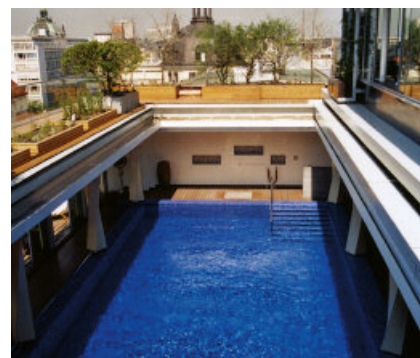
Tegels in een zwembad die zijn verlijmd met PCI Collastic.
