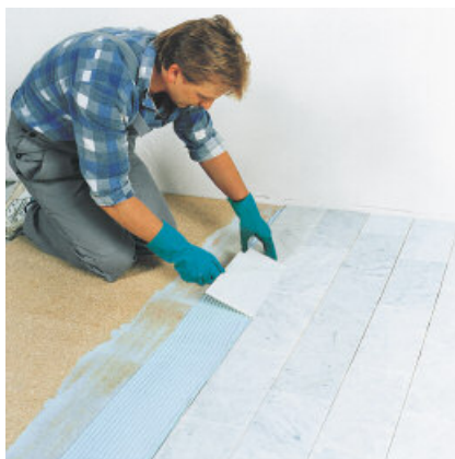
Met de reactieharstegellijm PCI Collastic kan ook natuursteen op houten spaanplaten worden gelijmd.
