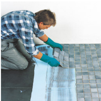
Tegels worden in het opgekamde lijmsbed geplaatst.
