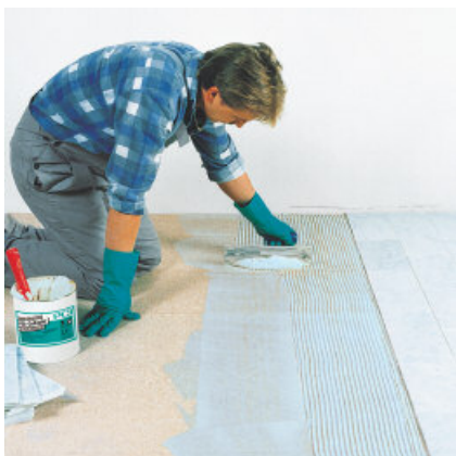
PCI Collastic is geschikt als tegellijm op ondergronden die gevoelig zijn voor vocht, zoals houten spaanplaten.
