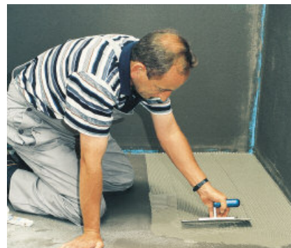
Tegellijmen waaraan PCI Lastoflex is toegevoegd verminderen ondergrondspanningen en compenseren spanningen die door temperatuurschommelingen worden veroorzaakt.
