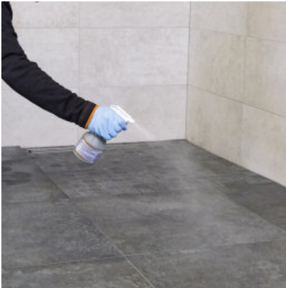
Besproeien met PCI Durapox Finish (vloeibaar) voor de laatste wasbeurt
