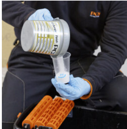
OF: Toevoegen van PCI Durapox Finish (geconcentreerd) poeder aan het waswater, mengverhouding 1:100
