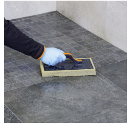
Laatste wasbeurt: Reinigen van het oppervlak
