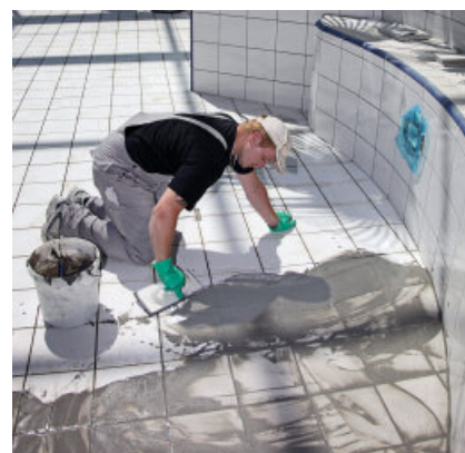
PCI DURAFUG NT voor het voegen van keramische afwerkingen met verhoogde mechanische belasting, bijv. in zwembaden.
