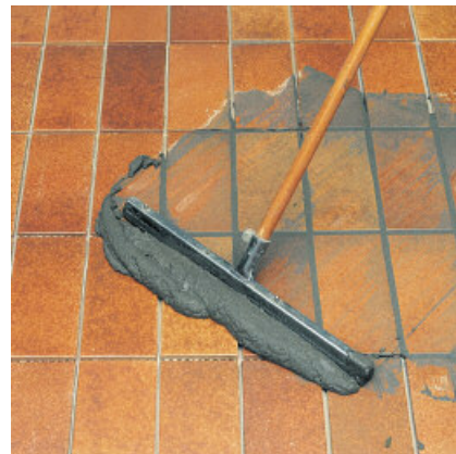
Voldoende PCI FT Fugenbreit gelijkmatig in de voegen werken....
