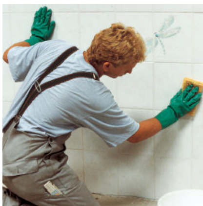
De achterblijvende cementsluis met een vochtige doek verwijderen.
