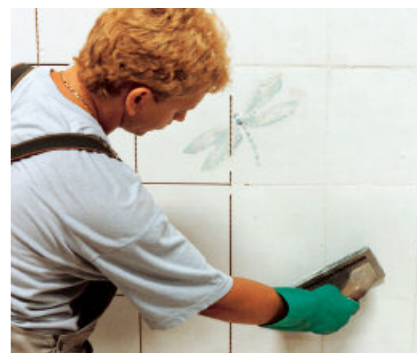
Met PCI FT Fugengrau en PCI FT Fugenweiß kunnen voegen van 2 tot 8 mm scheurvrij worden afgevoegd.
