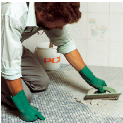
Voldoende voegmortel met gummispaan in de voegen werken.
