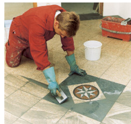
De voegen van dubbelhardgebakken keramiek met lage wateropname met een breedte van 1 – 10 mm kunnen met PCI FT® Megafug worden gevuld.
