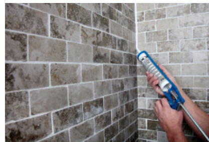
Door het afkitten met PCI Carraferm ontstaan geen randzoneverkleuringen bij natuursteen.
