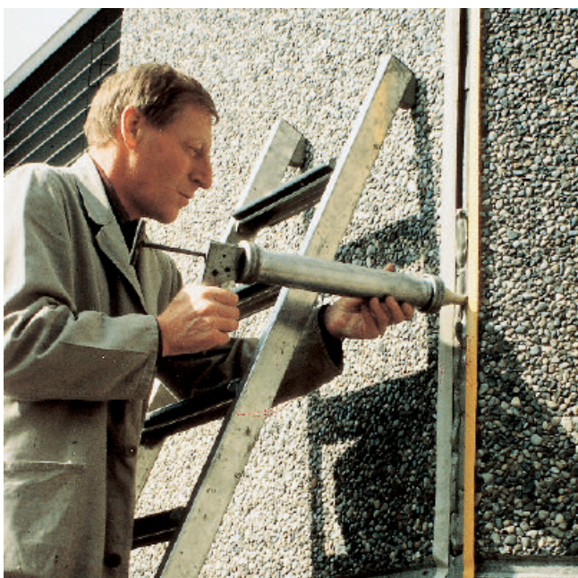
Afdichten van een bewegingsvoeg met PCI Elritan 100 op een gevel van gewassen beton.
