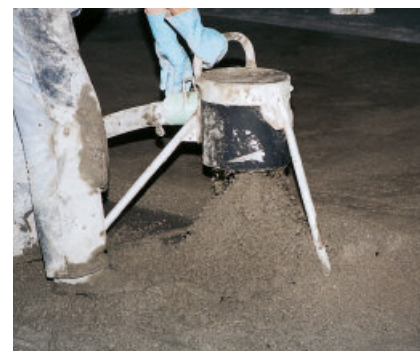
PCI Novoment Z3 voor snel hardende cementdekvloeren heeft een lange verwerkingstijd van ca. 1 uur en is, ook bij hoge temperaturen, geschikt voor verpompen.
