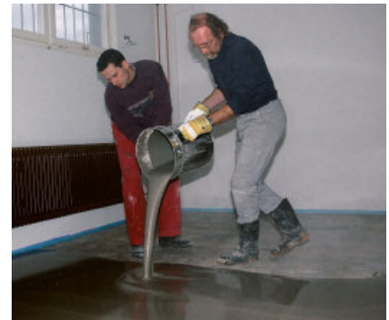
Eenvoudige en functionele vloeregalisatie met PCI Periplan voor het verlijmen van keramiek.
