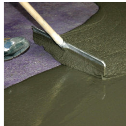
Daarna met een stiftrakel of trapeziumgetand spackmes verdelen en met een rij afwerken.
