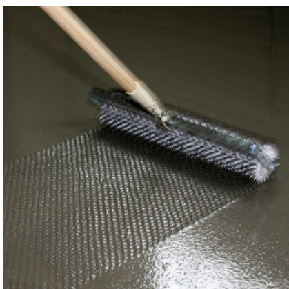
Ontluuchten met een ontluuchtingsroller.
