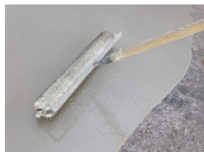
Op de lijmrije en gedroogde grondering PCI Zemtec 1K gieten en verdelen, en tijdens het aanbrengen met een stekelwals ontluchten.
