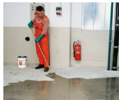
Impregneren van een betonnen oppervlak met PCI Apogrund om afzanden tegen te gaan en de slijtvastheid te verhogen.
