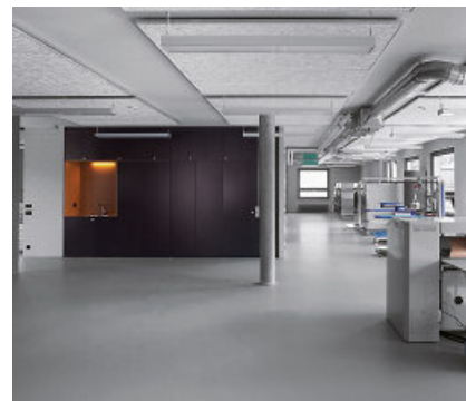
Een met PCI Apoten PU gemaakte, slijtvaste en chemicaliënbestendige coatinglaag.
