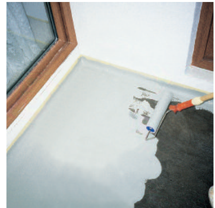
De scheuroverbruggende PCI Pursol 1K is gebruiksklaar en kan eenvoudig met een kortharige roller worden aangebracht.
