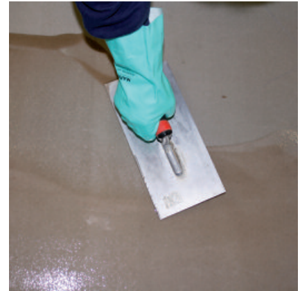
Alleen op een gesloten, poriënvrije schraaplaag met PCI PUR-Grund met kwartszandmengsel ontstaat een goede hechting en luchtbelvrije uitharding van PCI Pursol 1K.
