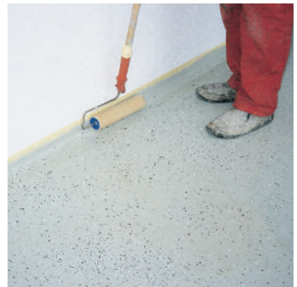
De met gekleurde chips ingestrooide eerste laag gekleurde PCI Pursol 1K moet, om een langdurige bescherming te krijgen, overlaagd worden met PCI Pursol 1K transparant.
