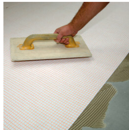
en met een gummispaan aangedrukt
