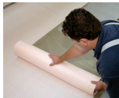
Met PCI Pecilastic kan keramiek en natuursteen worden ontkoppeld.
