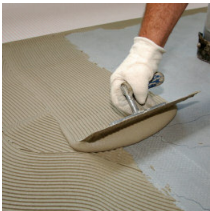
In de vers aangebrachte lijmlaag
