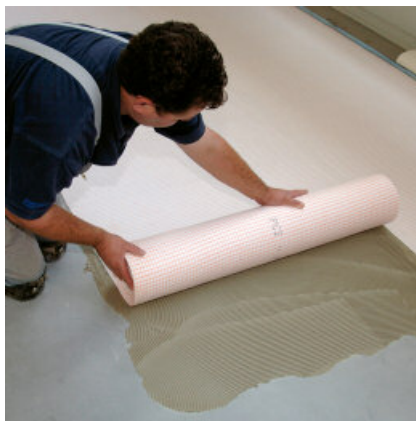
worden de PCI PECILASTIC banen aangebracht
