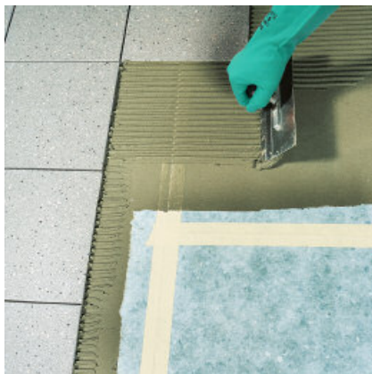
5. Zonder dat een grondering nodig is kan dan keramiek ...
