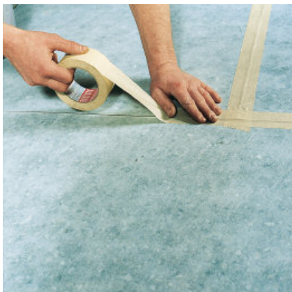
4. Om geluidsbruggen tegen te gaan de stootkanten met band afplakken.
