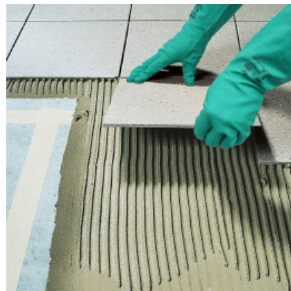
6. ...holtevrij worden verlijmd.
