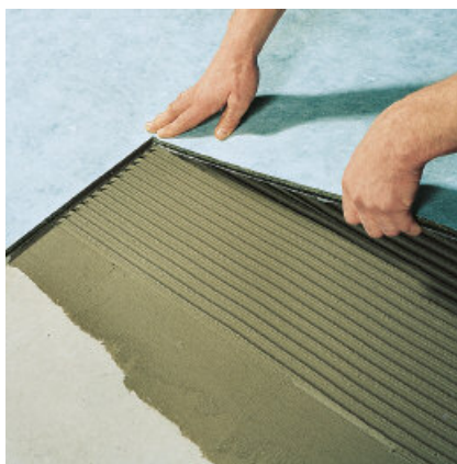
2. PCI Polysilent in het mortel bed leggen (kant met wit vlies naar boven) ...
