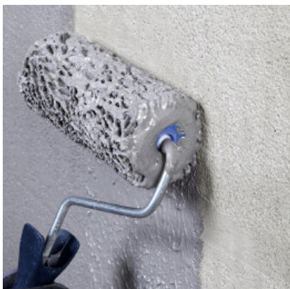
Aanbrengen van een contactlaag met een roller.
