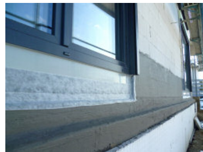
Afdichting van sokkel en overgang naar de basisafdichting met PCI Barraseal Turbo.
