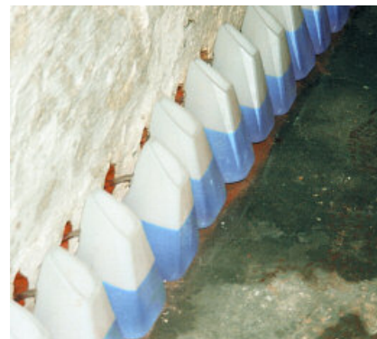
PCI Barra Gisol wordt minimaal 24 uur door middel van vloeistofhouders PCI Injektionsbehälter geïnjecteerd.
