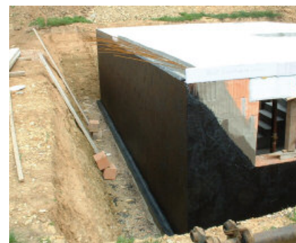
Afdichting van kelderbuitenmuur van beton met PCI Pecimor 2K.
