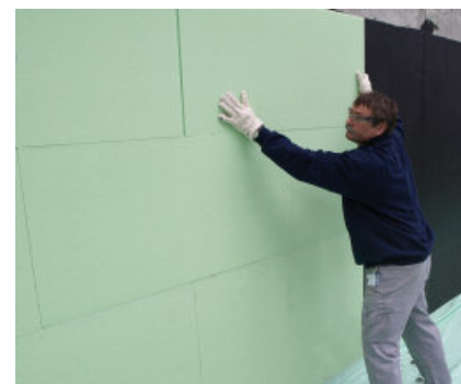
Door middel van schuiven plaatsen van isolatieplaten in het lijmbed van PCI Pecimor DK.
