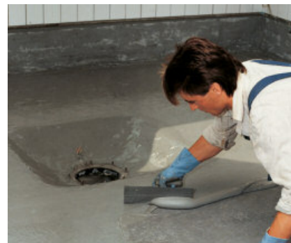
Het aanbrengen van PCI Apoflex F voor het afdichten onder keramiek in een grootkeuken.
