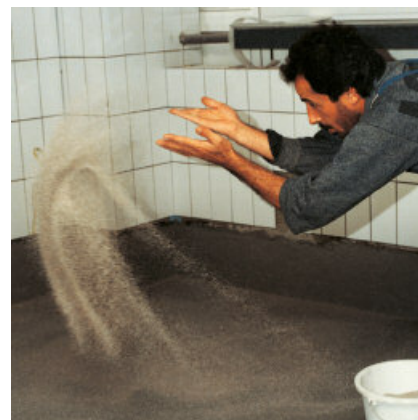
... en wordt kwartzand (korrel 0,3 tot 0,8) in de verse laag gestrooid.
