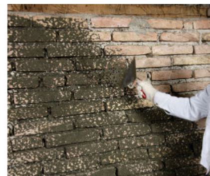
Een met PCI Emulsion aangemaakte spatlaag verbetert de hechting van de pleister.
