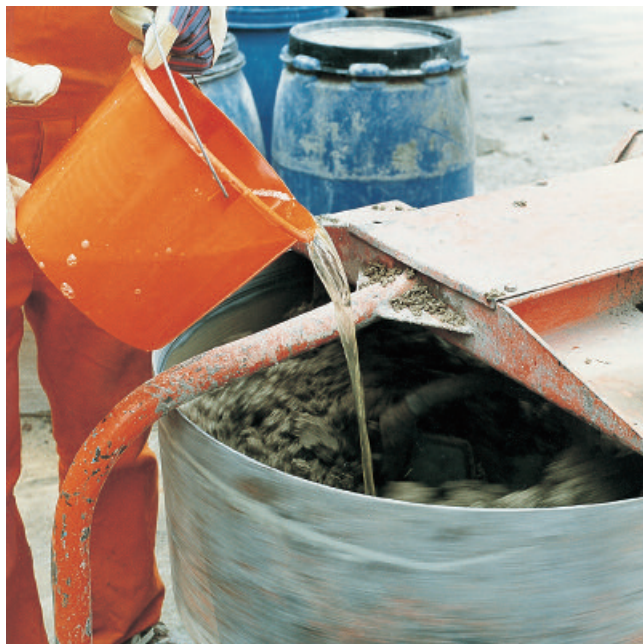
Het aanmaakwater met de PCI Mischöl wordt aan de mortel toegevoegd.
