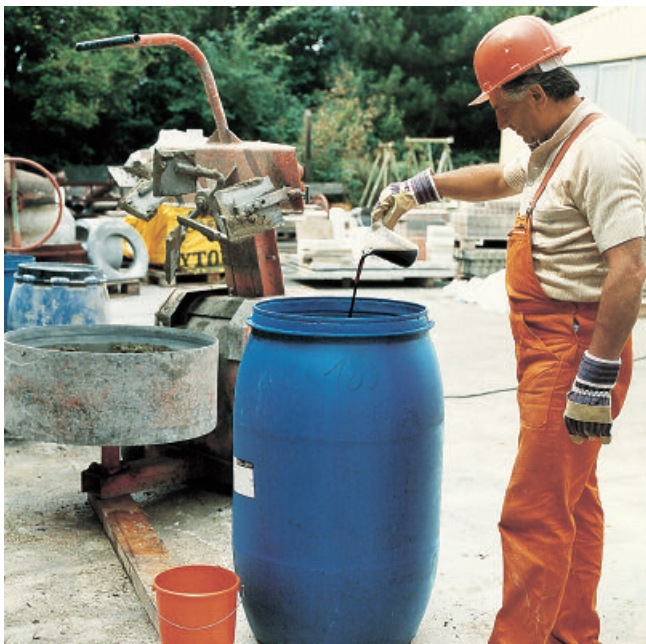
PCI Mischöl wordt aan het aanmaakwater toegevoegd.
