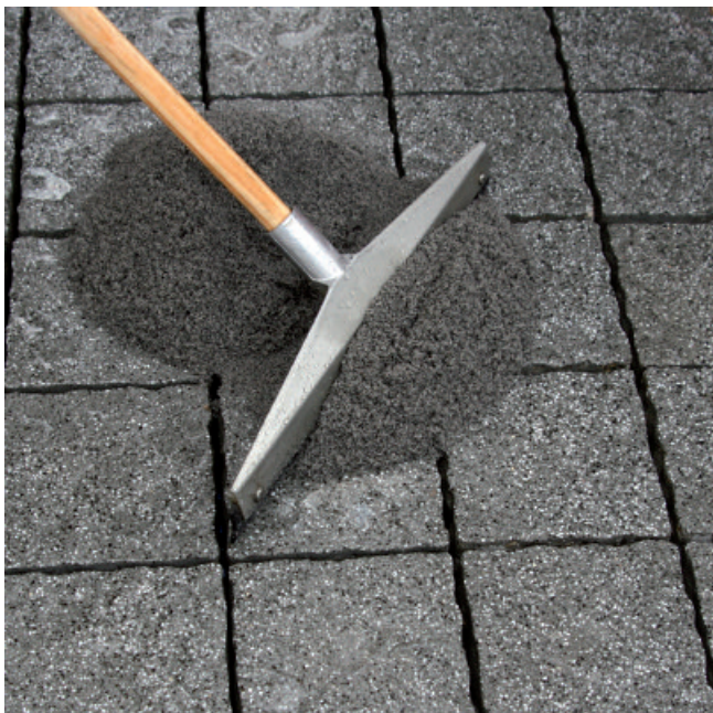
PCI PAVIFIX 1K EXTRA met een harde rubberwisser onder druk in de voegen aanbrengen.
