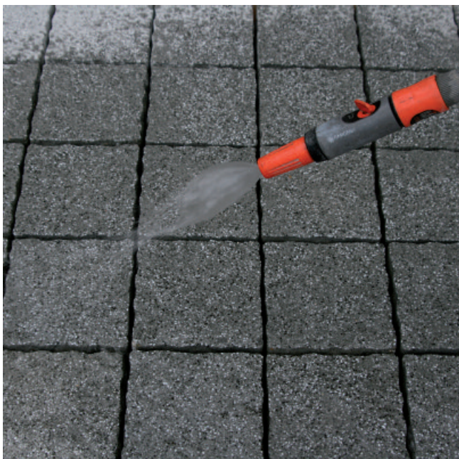
Voor het afvoegen het oppervlak (boven- en zijkanten) en de voegen grondig voorbevochtigen.
