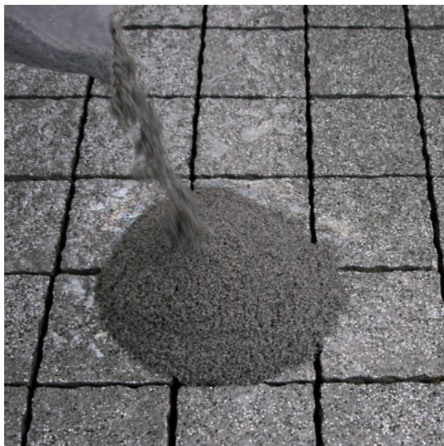
Een zak PCI PAVIFIX 1K EXTRA openen en het materiaal op het natte oppervlak gieten.
