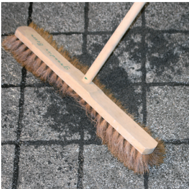
De mortelresten met een zachte bezem diagonaal volledig van het oppervlak vegen.
