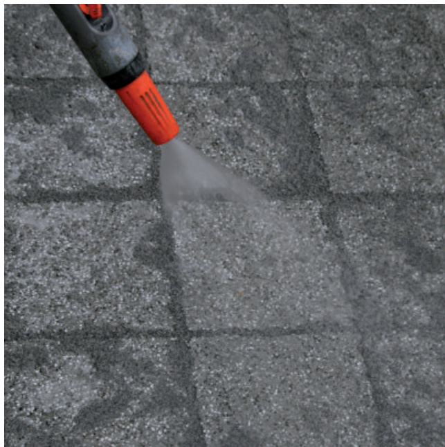
Bij voegen van 3 - 8 mm de verdeling van de voegmortel ondersteunen met een zachte waterstraal. Bij zeer smalle voegen hierbij de voegen volgen. Ingezakte voegen meteen met vers materiaal bijvullen.
