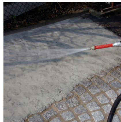
Om bij het reinigen van de bestrating te voorkomen dat de voegen uitspoelen, de waterstraal bijna horizontaal aan het oppervlak houden.
