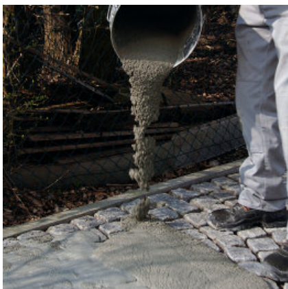
Aanbrengen van PCI PAVIFIX CEM op het oppervlak.
