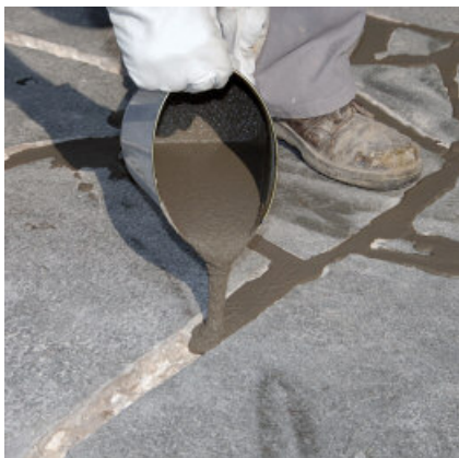
PCI PAVIFIX CEM in de voegen gieten.
