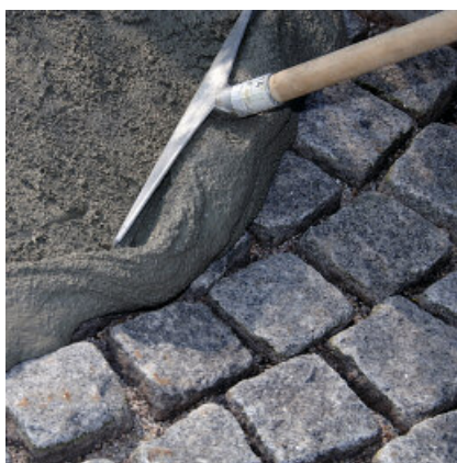
PCI PAVIFIX CEM RAPID met een gummiwisser in de voegen werken. Het oppervlak via verneveling nat houden
