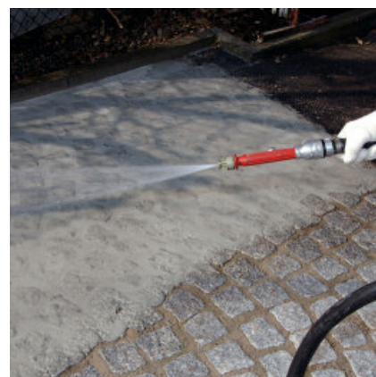
Na aantrekken van de mortel (vingertoppentest) de resten op het oppervlak met water en een zachte bezem losmaken. Vervolgens het oppervlak reinigen door af te spuiten.
