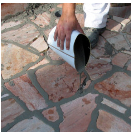
PAVIFIX CEM RAPID in de voorbereide voegen gieten.
