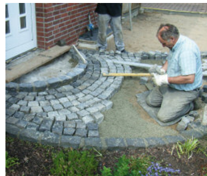
Het aanbrengen van bestrating met PCI Pavifix DM.
