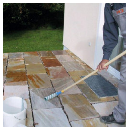
Het aanbrengen van PCI Pavifix V voor het afvoegen vergemakkelijkt het later resten van het oppervlak te verwijderen en behoudt de natuurlijke uitstraling van natuursteen.
