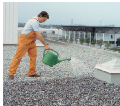
PCI Stabiflex verstevigt grindlagen op platte daken en verhindert dat grind wegglijdt.
