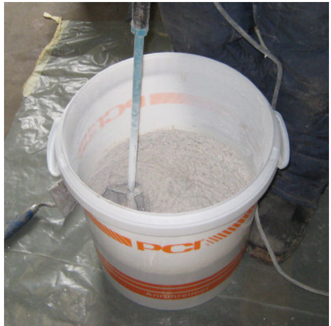
Ca. 1 minuut mengen tot een homogene en klontvrije massa wordt verkregen.
