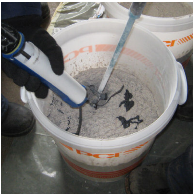
Dan component B toevoegen en nogmaals minimaal 2 minuten mengen.
