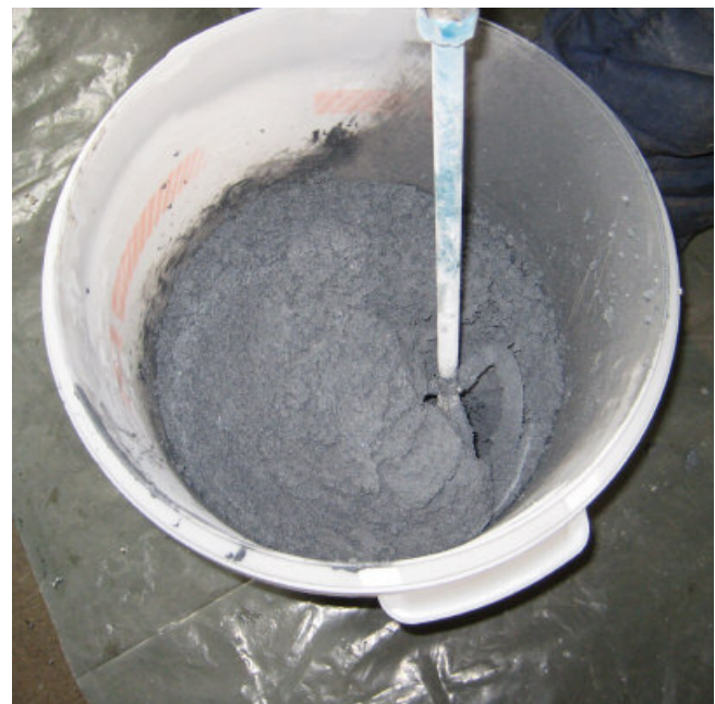
Gemengd materiaal overgieten om mengfouten aan de rand van de emmer te vermijden. Zonodig namengen.
