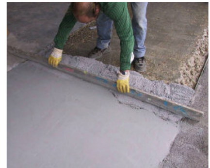
Oppervlakken met mechanische belasting kunnen zonder primer met PCI Repafast APS 40 tot -25^{\circ}\text{C} worden gerepareerd.
