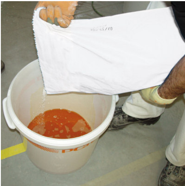
De zak met component C uit de emmer halen. De inhoud van component A in de emmer gieten en component C toevoegen.
