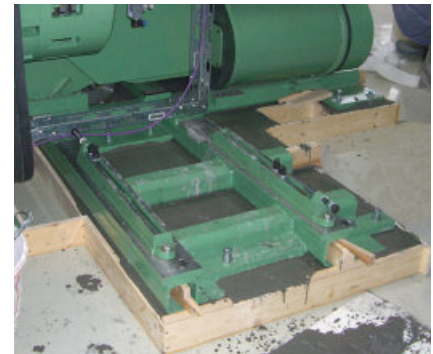
Aangieten van een verankering van een machine met PCI Repaflow.
