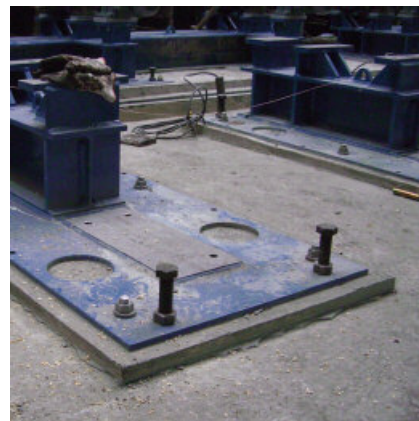
Met PCI Repaflow ontstaat een naadloze, scheurloze en holtevrije verbinding, die een rustig machineverloop en nauwkeurig werken mogelijk maakt en de slijtage van machines vermindert.
