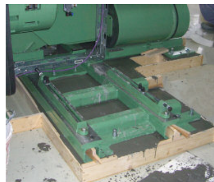
Met PCI Repaflow Uni worden krachtverdelende verbindingen tussen beton en staal gelegd.
