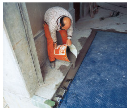
Ingieten met PCI Repaflow Turbo bij een laadplaats
