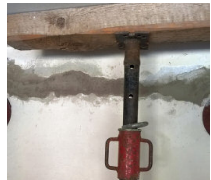
Vullen van een gleuf in een dragende muur met PCI Repaflow USM.
