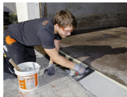
Met PCI Aposan kunnen zelfs zwaar belaste garagedrempeld slijtvast en duurzaam worden gerepareerd.
