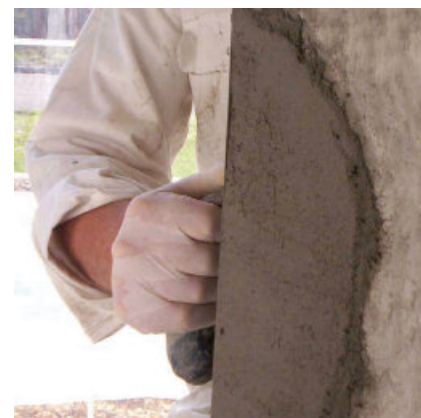
Reparatie van hoeken is één van de vele mogelijkheden die PCI Nanocret R2 biedt.
