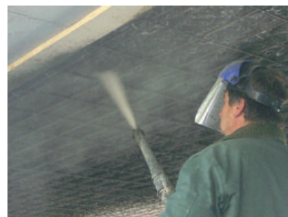
PCI Nanocret R4 Sm is een zeer sterke reparatiemortel, die zowel handmatig als machinaal bovenhoofds aangebracht kan worden.
