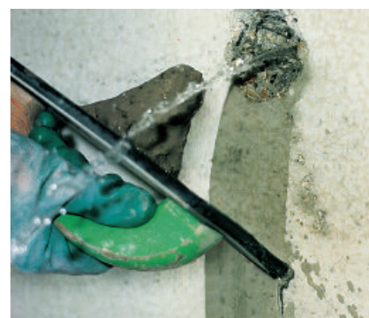
Met snelcement PCI Polyfix 30 Sek. kunnen lekkages snel worden afgedicht.
