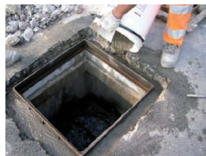
Aangieten van een rioolschachtring met PCI Repafast Fluid.
