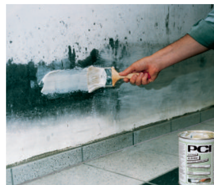
Aanbrengen van pasta PCI Entöler op een oliehoudende ondergrond, hier op een wand na waterschade.
