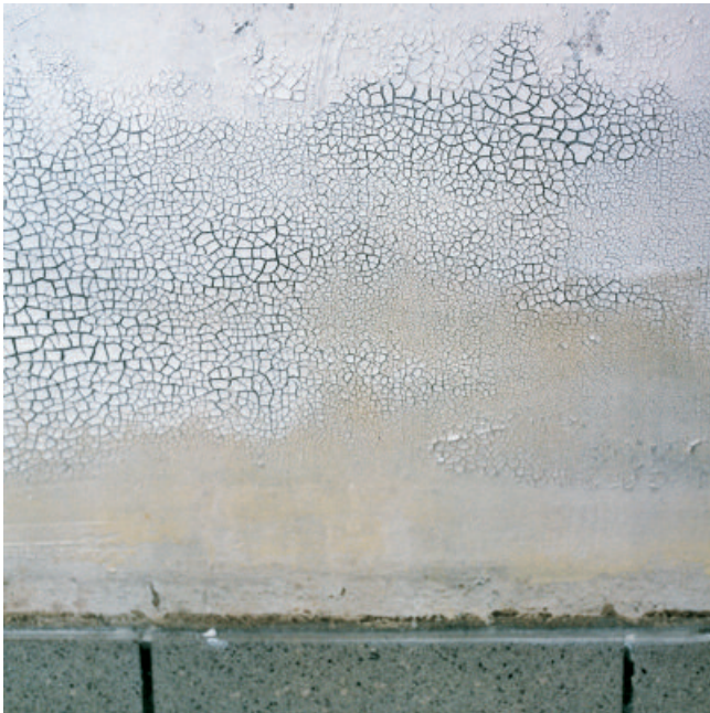
Aangebrachte pasta PCI Entöler bindt de opgeloste vervuiling en droogt als korsten op.
