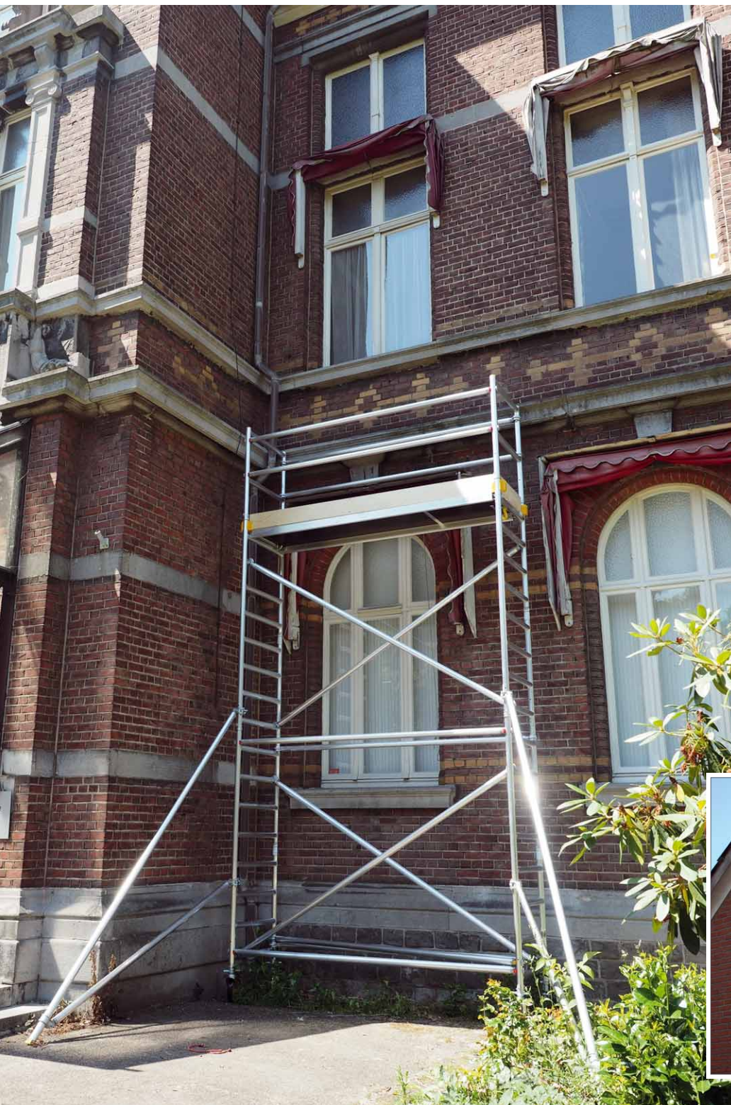
Die Arbeitsplattform wird durch eine Klappe im Boden der Arbeitsfläche betreten
