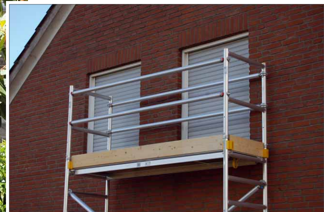
Die Arbeitsplattform wird durch eine Klappe im Boden der Arbeitsfläche betreten
