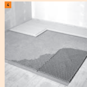
4 Het FERMACELL Honingraatsysteem afreien
