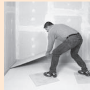
Leggen van de vloerelementen
