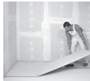
Leggen van de vloerelementen
