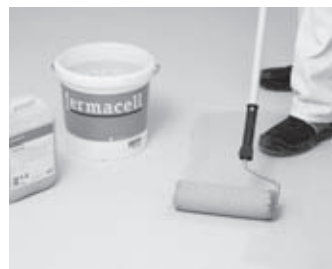
Ondergrond gronderen en randstroken aanbrengen
