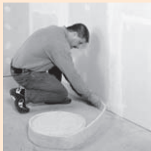
Randisolatiestroken aanbrengen
