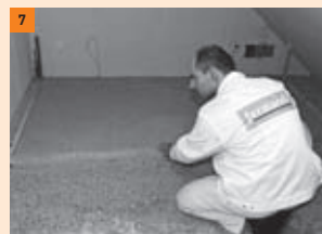
7 Wanneer het gebonden egalisatiemiddel tussen de dammen gestort is, kan het afreien beginnen
