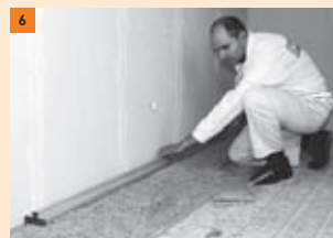
6 De tweede dam storten op het niveau van de eerste dam
