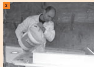
2 8 tot 10 liter water per zak toevoegen
