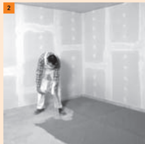
2 Het FERMACELL Honingraatelement met FERMACELL Honingraatkorrels vullen
