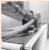
Afsagen van lipllas voor eerste rij platen
