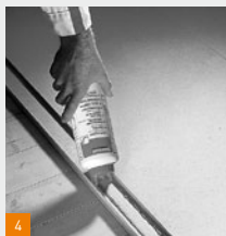
4 Aanbrengen lijm
