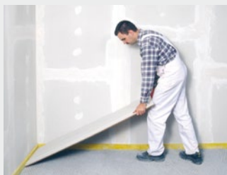
Leggen van de vloerelementen
