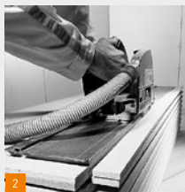
2 Afzagen van liplas voor eerste rij platen
