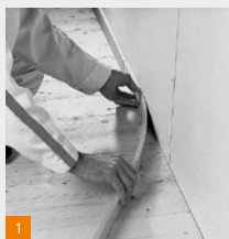
1 Aanbrengen randstrook
