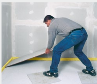
Leggen van de vloerelementen
