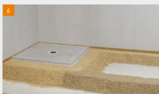
6 Wacht totdat de dam enigszins is aangedroogd (ca. 20 min.)
