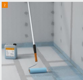
... en met een roller aanbrengen
