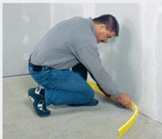
Randisolatiestroken aanbrengen
