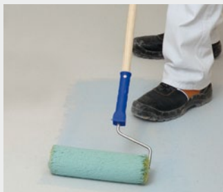
Ondergrond gronderen en randstroken aanbrengen
