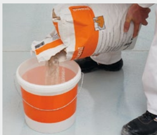
Zakgoed in emmer strooien cf. verwerkingsrichtlijn
