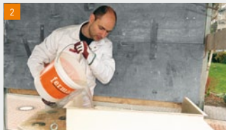
2 8 tot 10 liter water per zak toevoegen
