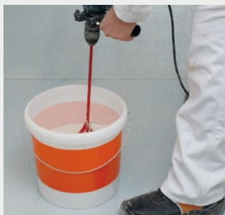
In een schone emmer mengen 6,5 l water per 25 kg
