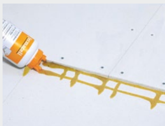
Lijmstrook aan de rand van de plaat
