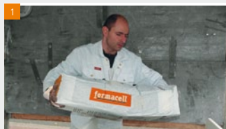
1 Inhoud van een volle zak in de betonmixer aanmaken
