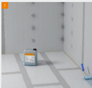
fermacell Diepgrond in de daarvoor aangewezen zones ...
