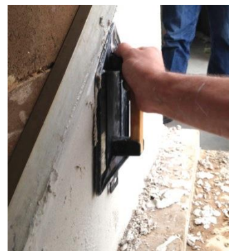
Aanbrengen met het plastic plakspaan
