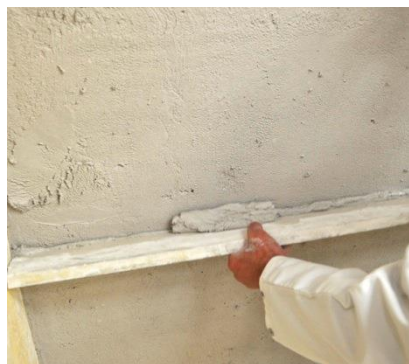
Aanbrengen met de regel
