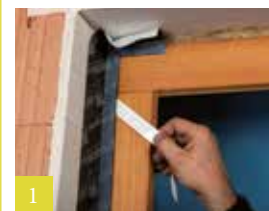
1 Op kozijn verlijmen
