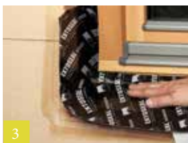
3 In de dagkant vastplakken
