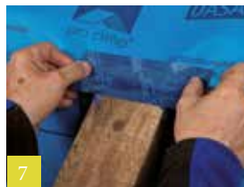
7 Vastplakken op bovenkant spant
