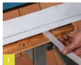
1 Aan de zijkant op het kozijn verlijmen
