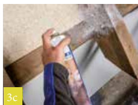
3c Primer aanbrengen
