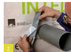
2 De eerste afdekfolie verwijderen
