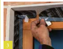
3 Raam rondom en over de hoeken verlijmen
