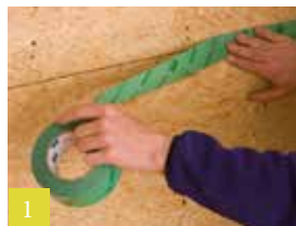
1 Voorbereiden / Verlijming plaatvoegen
