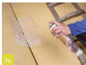
1 Ondergrond reinigen
