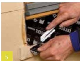
5 Horizontaal uitstekend band afsnijden
