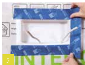
5 Luchtdicht aansluiten met TESCON VANA
