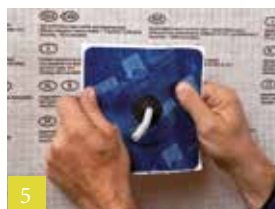
5 Aansluiting op kabels en buizen
