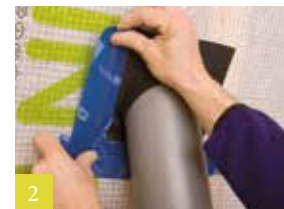
2 Manchet verlijmen en goed vastwijven
