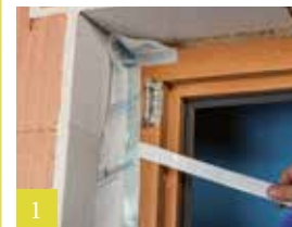
1 Op kozijn verlijmen
