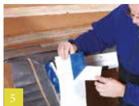
5 Aansluiting vlakdakraam
