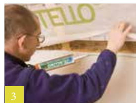
3 Aansluiting op gepleisterde borstwering
