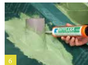
6 Op moeilijk toegankelijke plaatsen WYFLEXA uit de patroon aanbrengen
