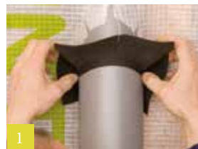
1 Manchet over de buis trekken en uitlijnen
