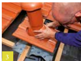
3 Ventilator met manchet opleggen
