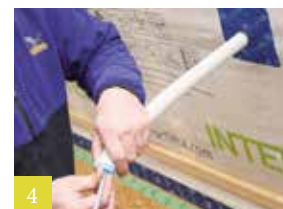
4 Luchtdicht verbinden met mantelbuis
