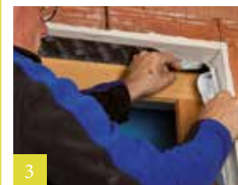
3 In de dagkant vastplakken
