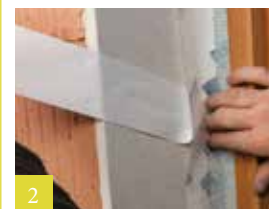
2 Met uitzettingsvouw op dagkant verlijmen
