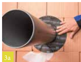
3a Met de ondergrond verlijmen
