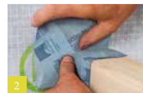
2 Verlijming op doorvoer
