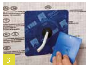
3 Manchet verlijmen en goed vastwrijven
