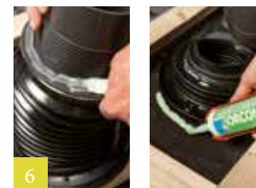
6 Aansluitlijm ORCON F of ORCON MULTIBOND opbrengen
