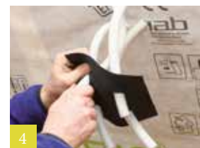
4 Lege buizen doorvoeren
