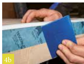
3 Verlijming op het wandoppervlak
