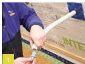
3 Kabel doorvoeren
