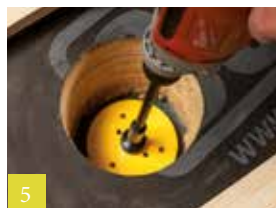
5 Damprem en beplanking doorboren
