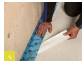
4a Verlijmen aan onderkant wand
