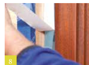
8 Gevelvenster – tweede flank verlijmen
