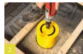
2 Onderdakbaan en isolatieplaat doorboren
