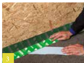
3 Op vloer vastplakken
