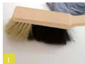
1 Ondergrond reinigen
