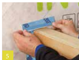
5 Aansluiting met kort kleefbeen
