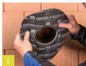
1 Manchets over de buis schuiven
