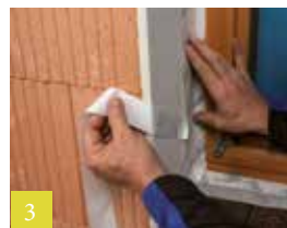
3 In de dagkant verlijmen en aanwrijven
