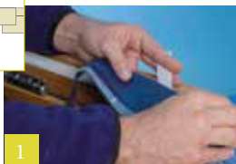
1 Band op het kozijn vastkleven
