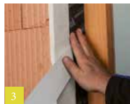
3 CONTEGA SOLIDO EXO-D in de dagkant verlijmen en aanrijve
