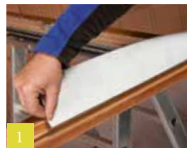
1 Aan de zijkant op het kozijn verlijmen
