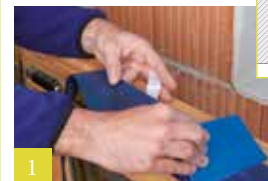
1 Band op het kozijn vastkleven
