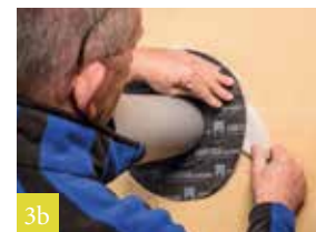
3b Met de ondergrond verlijmen
