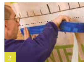
2 Baanoverlapping aanbrengen
