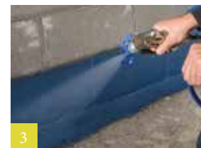
Spuitfolie aanbrengen (Airless-spuitmethode)
