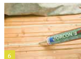
6 Aanbrengen luchtdichting buiten
