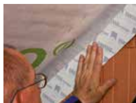
Gevelmuur gemetselde muur, luchtdichte aansluiting maken
