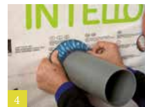
4 Op het vlak verlijmen
