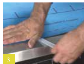
3 Scheidingsfolie verwijderen
