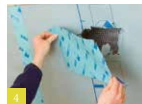
4 Detail reparatieverlijming
