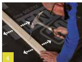
Tengellat positioneren en bevestigen
