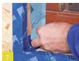
7 Gevelvenster – eerste flank verlijmen
