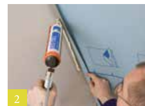
Aansluiting op gepleisterde gevelwand
