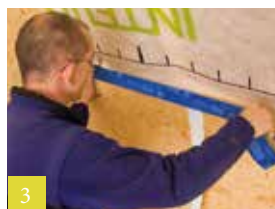
3 Aansluitingen op gladde, niet-minerale ondergronden
