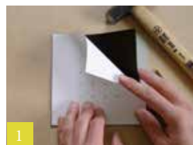
Onderlaag, EPDM en sjabloon uitlijnen
