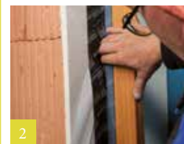
2 Met uitzettingsvouw op dagkant verlijmen
