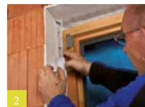
In de dagkant vastzetten en vastrijven
