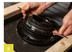
8 Op de onderdakbaan aansluiten
