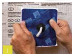
1 Kabel doortrekken en uitlijnen
