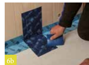
5 Aansluiting wand op bodemplaat/plafond
