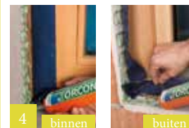
4 Band rondom in de dagkant vastkleven met ORCON F
